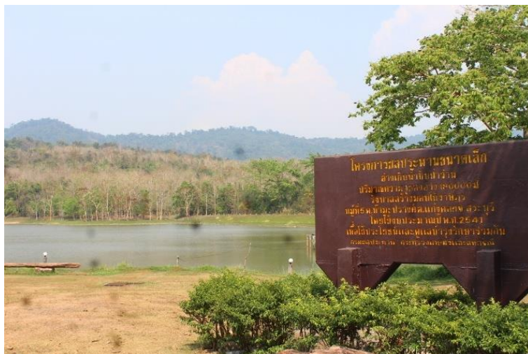
ภาพประกอบ 29 อ่างเก็บน้ำซับป่าว่าน
